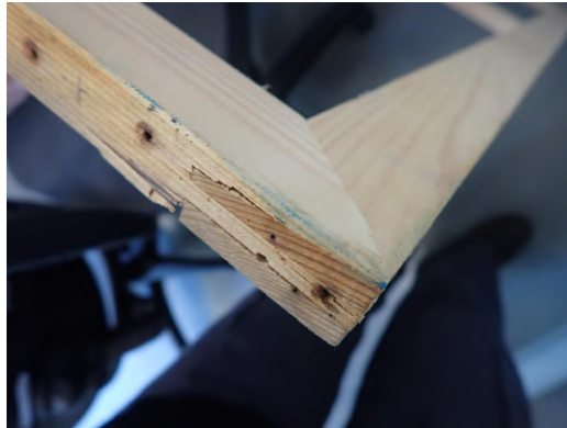
Assemblage à enfourchement
