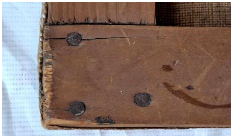
Fentes du bois des montants, localisées autour des clous de l'assemblage
