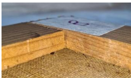
Vue du châssis avec ses étiquettes et inscriptions et vue détaillée de l'assemblage de deux montants à mi-bois
