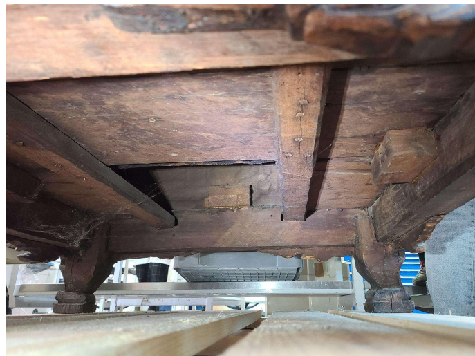
Figure 9 : Vue du dessous du podium. Les traverses assemblées par tenons/mortaises et clouées sont visibles.
