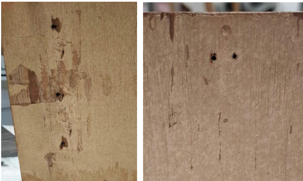
Altérations mécaniques au revers du panneau : traces d'arrachages et d'enfoncement, perte de fragments du plis inférieur du contreplaqué. Au centre, en partie supérieure : deux trous parallèles
