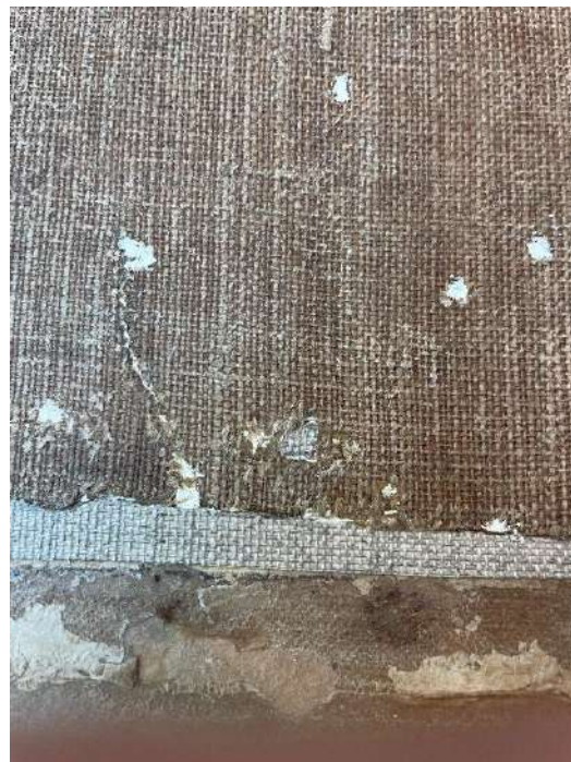
Détail après pose des incrustations
