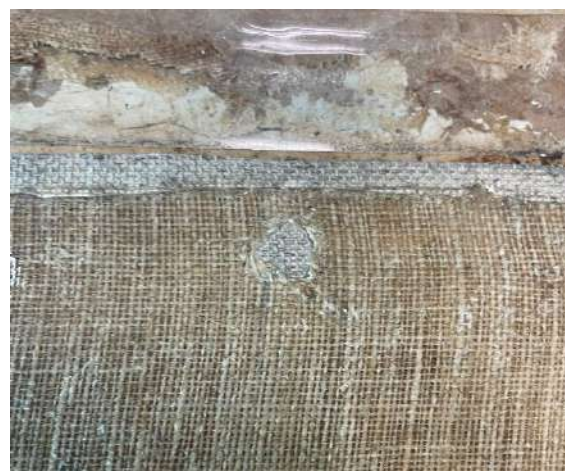
Détail après pose des incrustations
