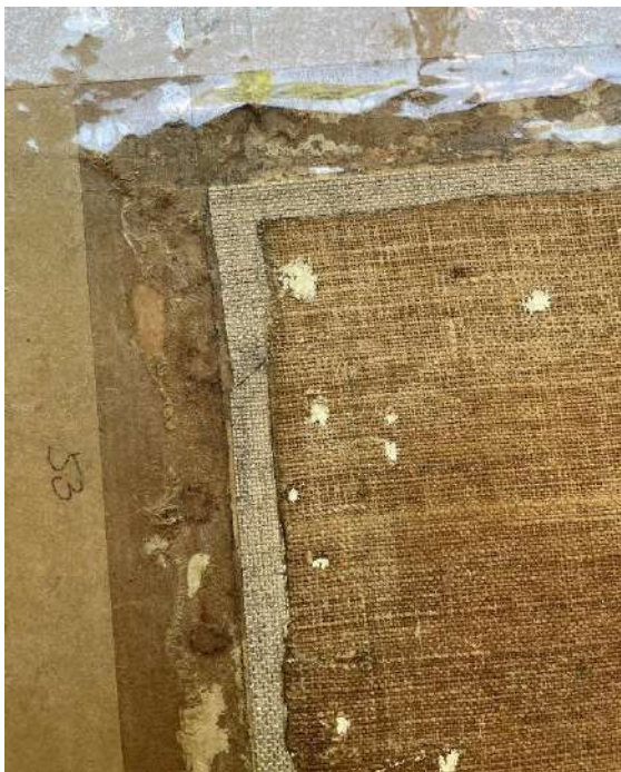
Détail après pose des incrustations
