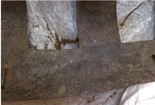
Figure 25: Aspect de surface après utilisation du scalpel et d'une nouvelle fois la sableuse
