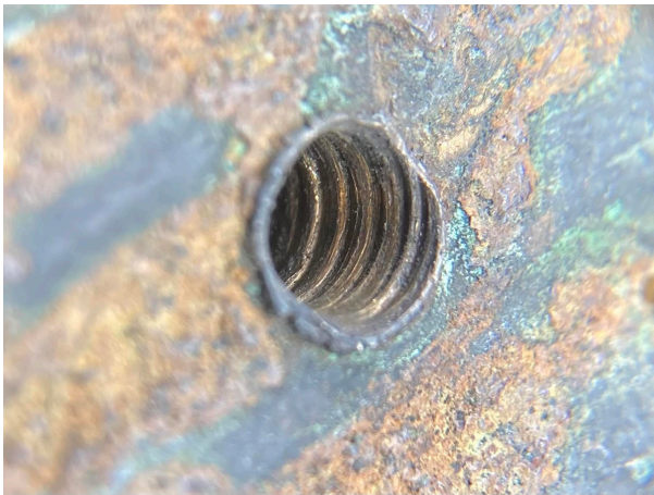
Photo du trou taraudé (pas « ancien » dont la norme de l'outil date d'avant le début du XXe siècle).
