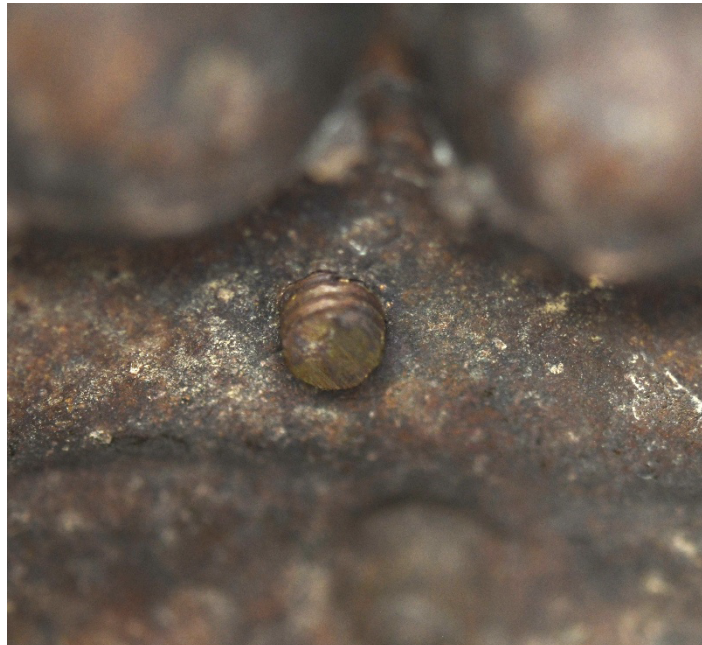
Fig.13 Clou distanciateur
