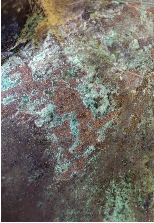
Fig.21 Détail avant nettoyage
