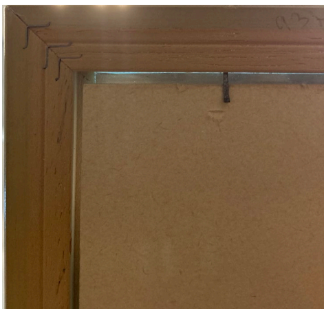
fig. 1 détail du système de maintien du cadre au revers.
