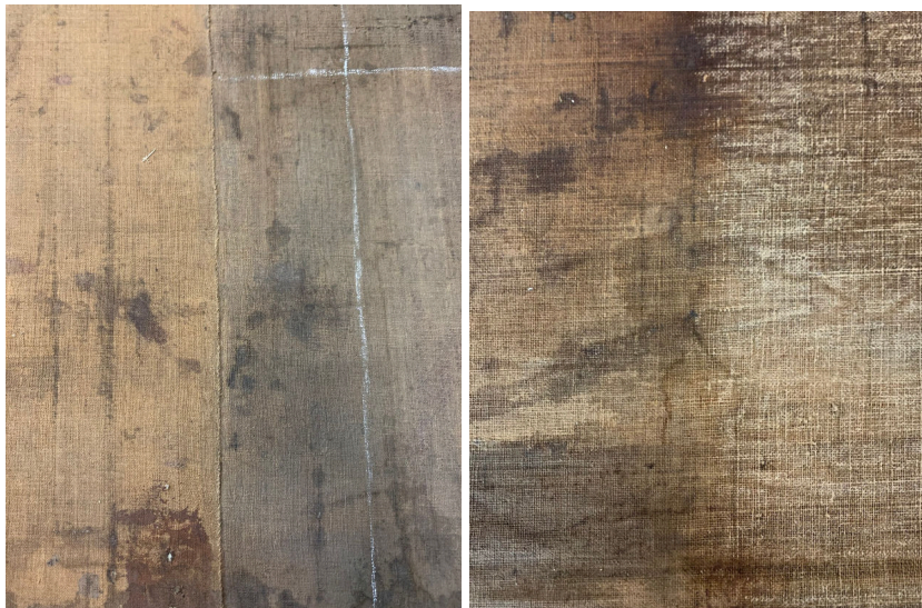
Photographies avant après du nettoyage (à gauche) et du dégrassage (à droite)
