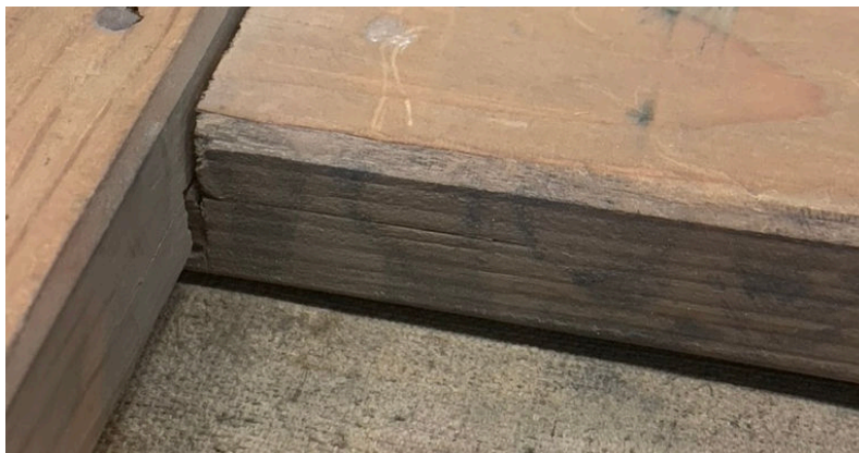
Photographie des traces de trusquin pour les assemblages
