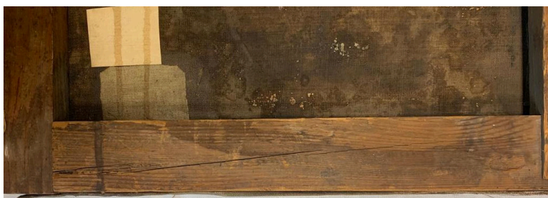
photographie de la fente sur le montant inférieur
