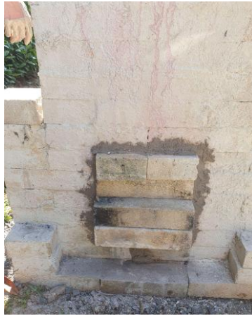
Fig. 8 : Ouverture principale scellée à l'aide de brique et de barbotine
