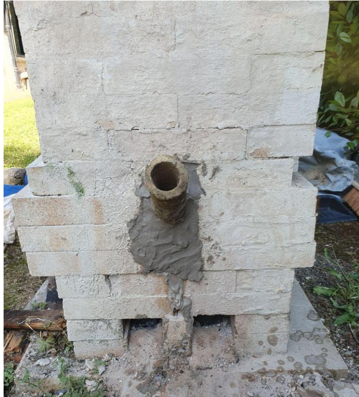
Fig. 6 : tuyère posée et enduite de barbotine
