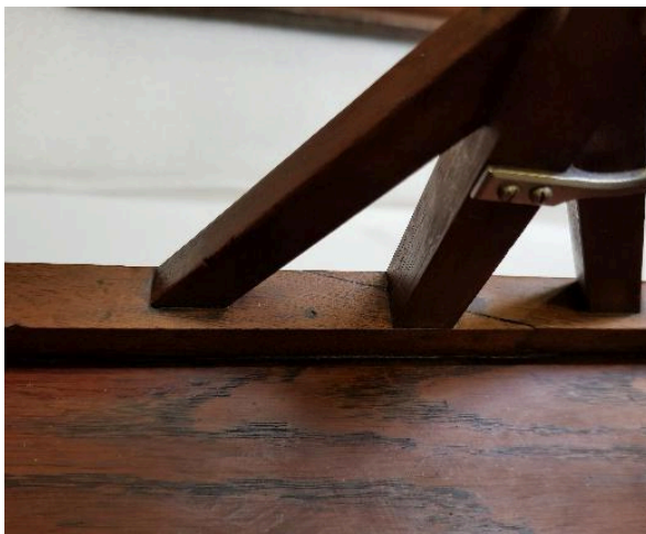
Figure 23 Fente partant du montant et fente du panneau
