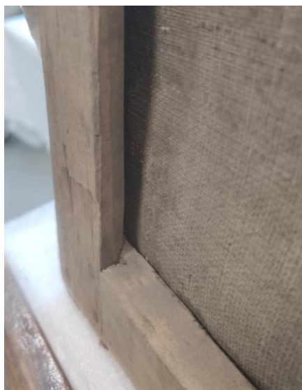
Assemblage des montants à mi-bois.
