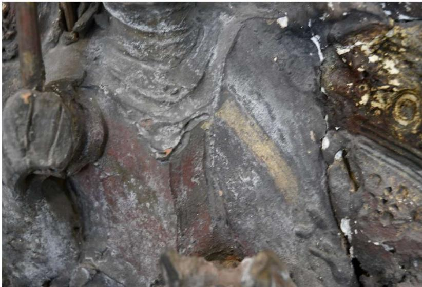
Efflorescence blanche sur l'armure et le bouclier d'un chevalier en arrière plan en haut à gauche de la sculpture.
