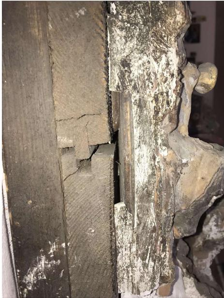
Assemblage par rainure et languette des deux planches horizontales de l'arrière de l'oeuvre
