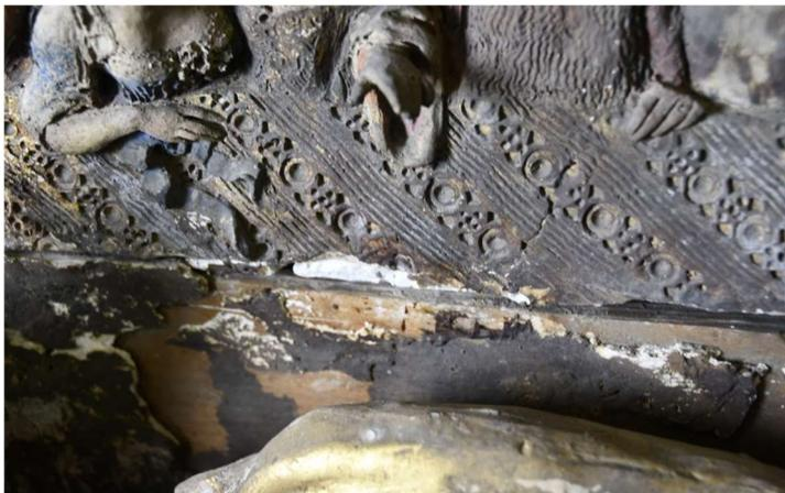
Joint ouvert entre le fond et la partie inférieure du balcon
