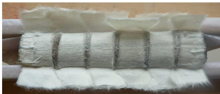
14 Après pose des claies dépassantes
