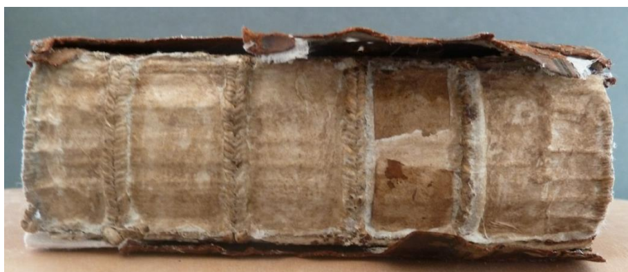
Repositionnement des anciennes claies et mise au ton de l'apprêt
