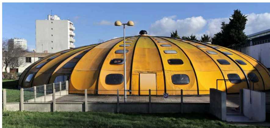
Piscine tournesol Raymond-Mullinghausen © Atlas de l'architecture et du patrimoine
