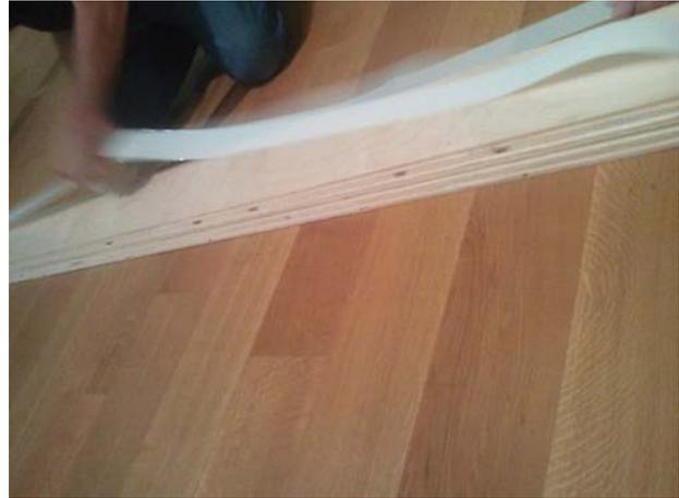
Fixation du velcro crochet sur le battant
