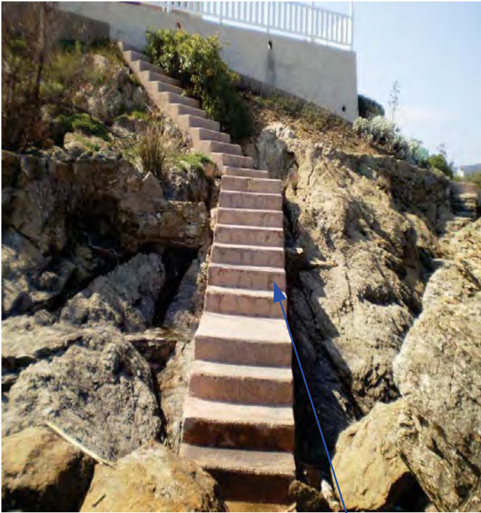
Démolition de 11 m 2 Un escalier
