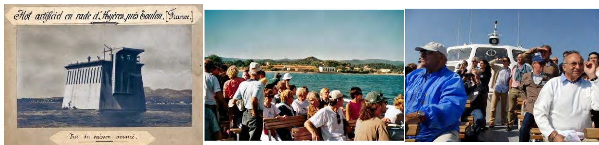
L'île lance-torpilles Schneider en rade d'Hyères, emblème d'une grande histoire industrielle / Le site industriel des Bormettes en vue, l'usine électrique servant d' amer depuis 1910 / Observateurs du paysage littoral vu depuis la mer, pendant l'expérimentation GIZC en 2006 ( Traits de côte, Arpents de mer )
