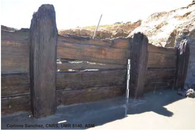
Elévation de palées latérales au Castelou, pour contenir les apports de matériaux
