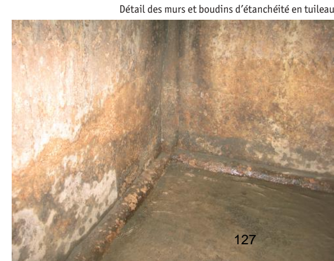
Détail des murs et boudins d'étanchéité en tuileau
