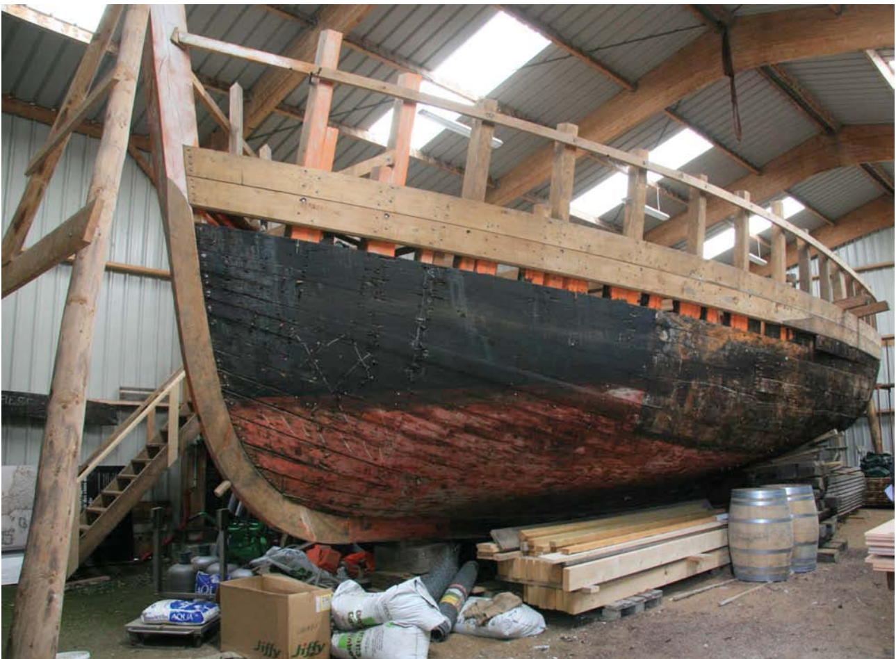
Le cordier Sainte-Thérèse-Souvenez-vous en cours de restauration
