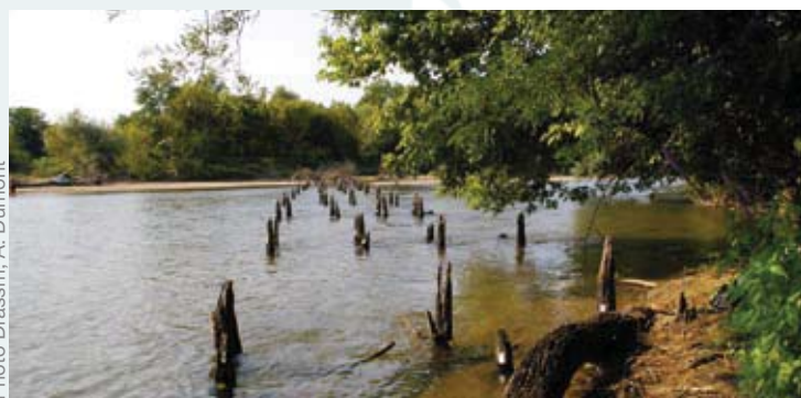
Pieux de fondation du pont médiéval de La Charité-sur-Loire.
