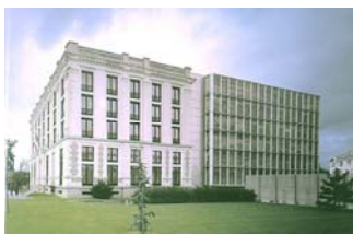
AD de la Mayenne - extension - Dominique Perrault architecte -1992/ 1993
