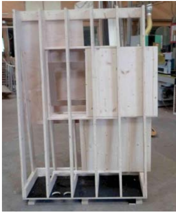
Face arrière structurale
