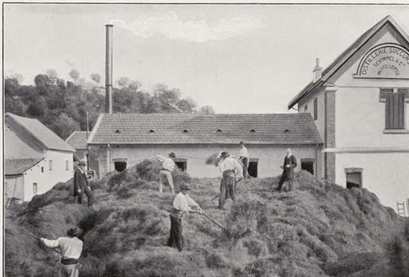
Distillerie d'essence de lavande de Schimmel & C ie à Barrême (Basses-Alpes). (Vue postérieure)
