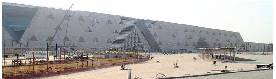
Grand musée égyptien en construction en novembre 2019, Caire © Djehouty
